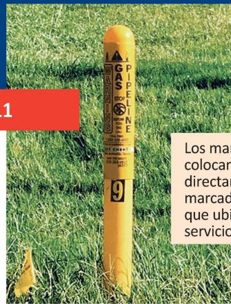
Los marcadores de las tuberías de gas natural se colocan cerca de las tuberías, aunque no directamente sobre ellas. Nunca utilice estos marcadores o mapas en lugar de llamar al 811 para que ubiquen y marquen las instalaciones de servicios dentro del área de excavación.
